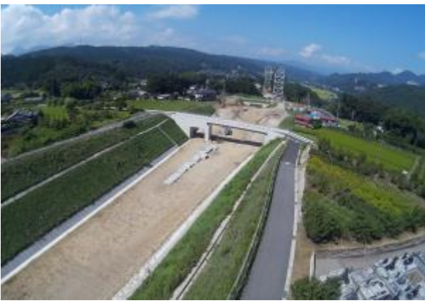
祖母島～箱島BP (仮称) 岡崎IC付近改良工事 9/5撮影
