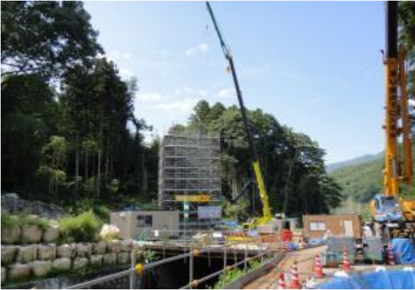
祖母島～箱島BP (仮称) 金沢川橋下部工工事 9/1撮影
