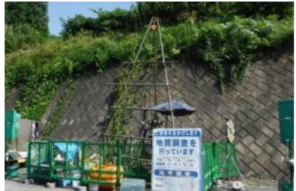
ボーリング作業の様子
