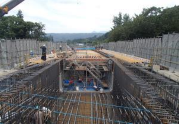
吾妻西BP (仮称) 鳶ヶ沢橋上部工工事 9/5撮影
