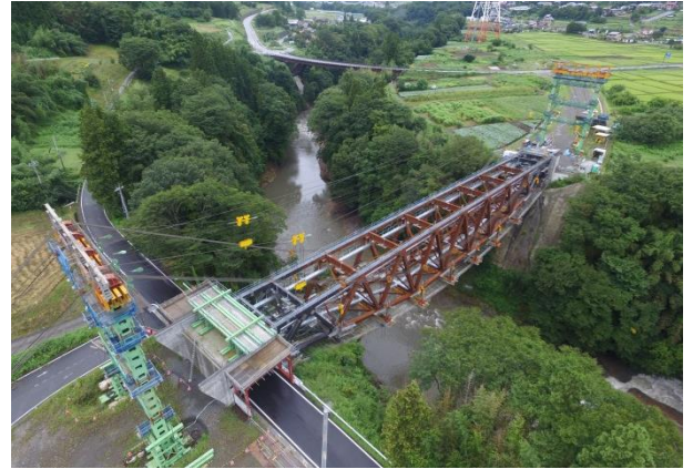
吾妻西BP (仮称) 吾妻川大橋上部工工事 8/31撮影
