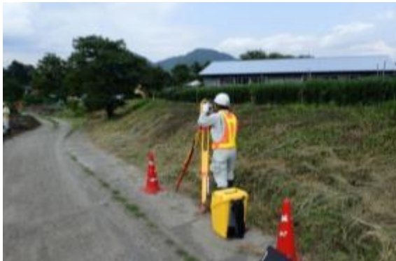
測量作業の様子
