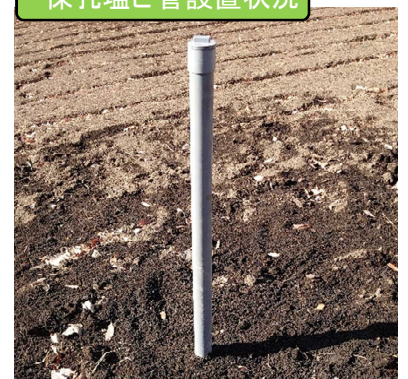
保孔塩ビ管設置状況
