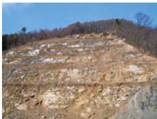
写真：土石採取を目的とした林地開発地
