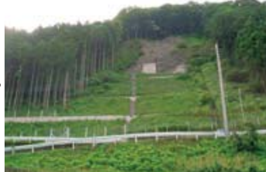
写真：山地災害の復旧
