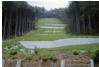
山腹崩壊復旧工事
