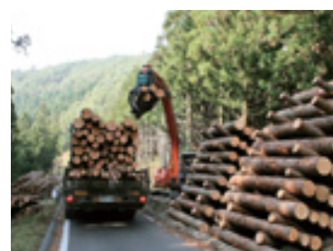
林道を利用した木材の運搬
