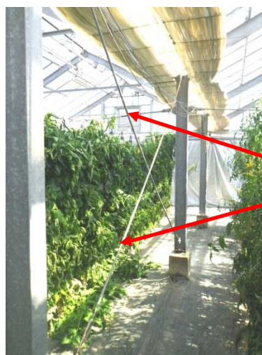
柱間ブレース
