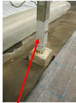
沓石と柱 (錆止めと腐食防止剤の塗布)
