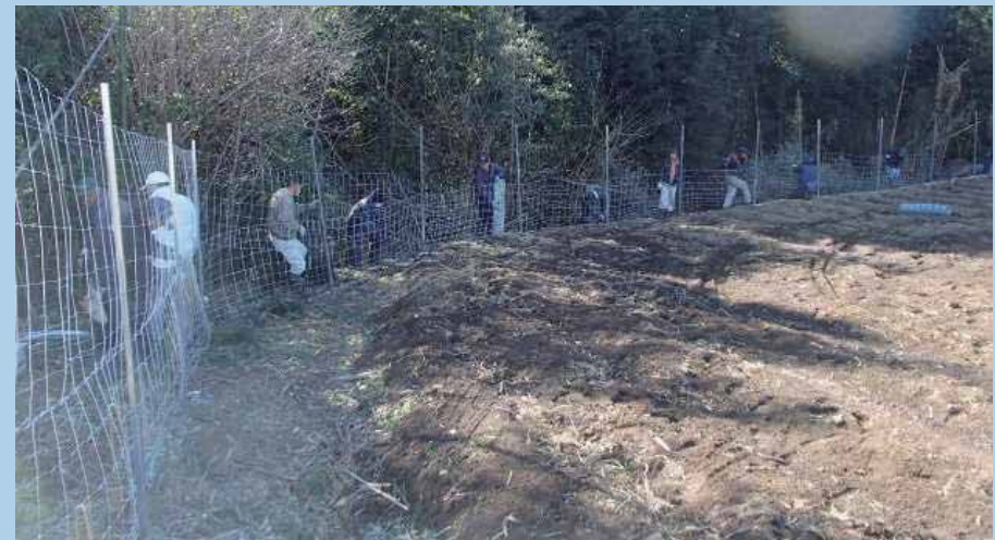
写真8 侵入防止柵設置
