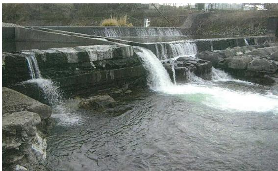
写真3 移動障害のある取水堰
