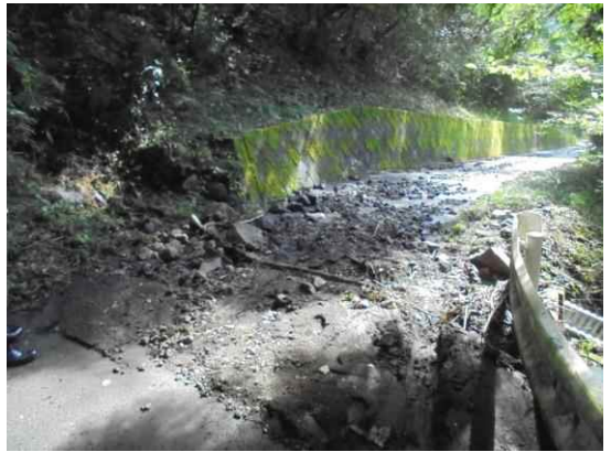
④令和元年 10 月 台風 19 号 土砂流出/音羽山線
