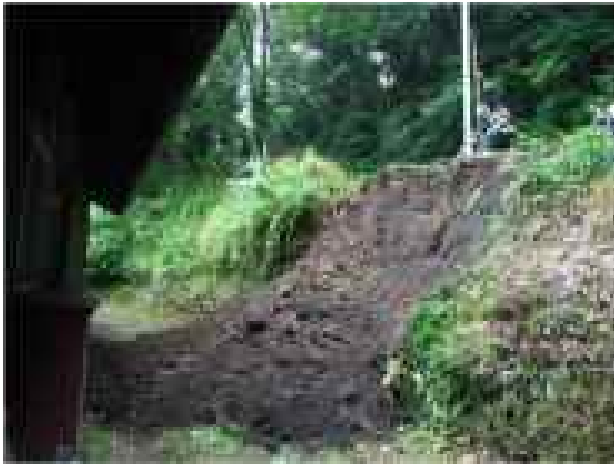
① 平成26年7月 豪雨により法面崩落(川浦)
