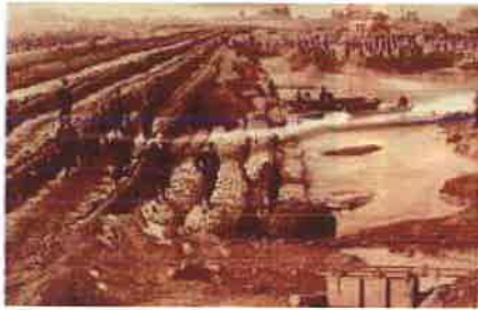
④利根川堤防復旧工事の様子(明治43年) (住民提供写真)
