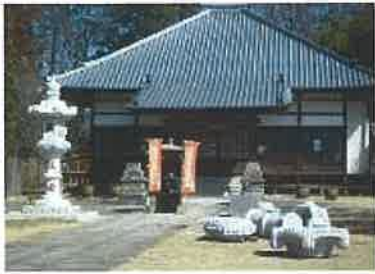
①石塔が倒れた光恩寺
