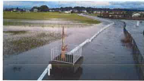
⑤中島地内の浸水の様子 (R1.10.13 早朝)
