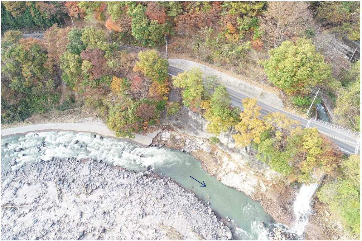
吾妻川 被災状況（長野原町羽根尾）
