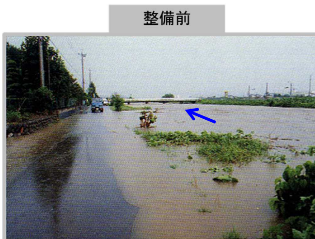
H6.9月 出水状況
