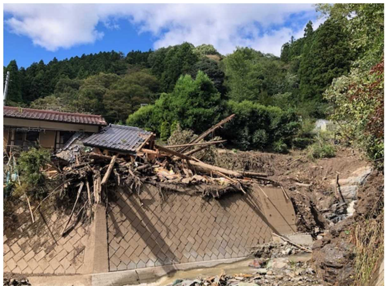
上平森沢地区 被災状況 (藤岡市上日野)
