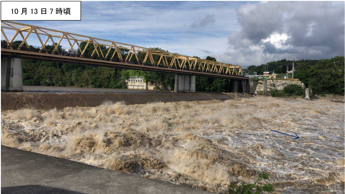
利根川(坂東大橋) 出水状況 (渋川市半田)
