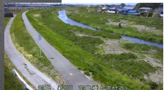
前島 (早川 前島橋上流付近)
