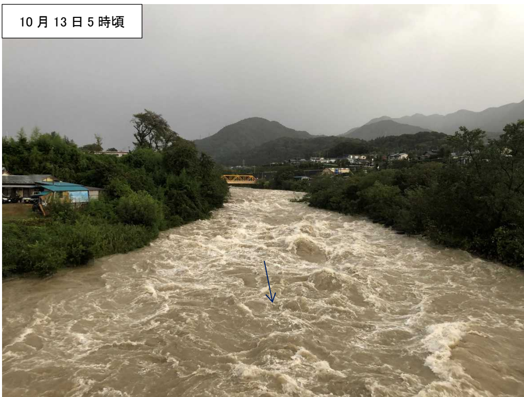
利根川(徒 ただ 渉橋) 出水状況 (みなかみ町月夜野)
