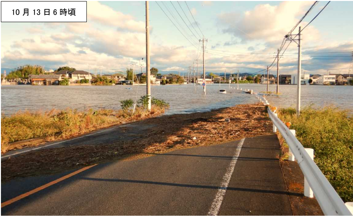
内水氾濫状況（太田市牛沢町）一般県道妻沼小島太田線 牛沢橋付近（遠景）
