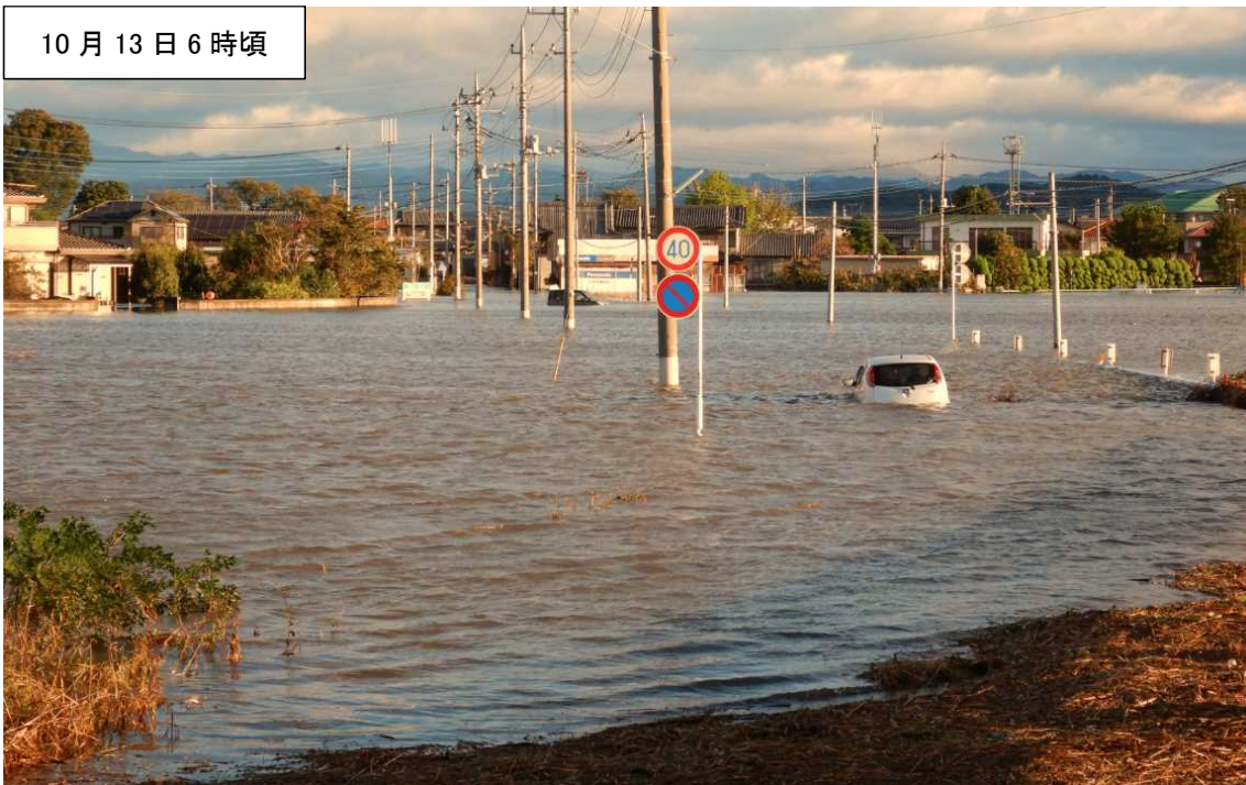
内水氾濫状況（太田市牛沢町）一般県道妻沼小島太田線 牛沢橋付近（近景）
