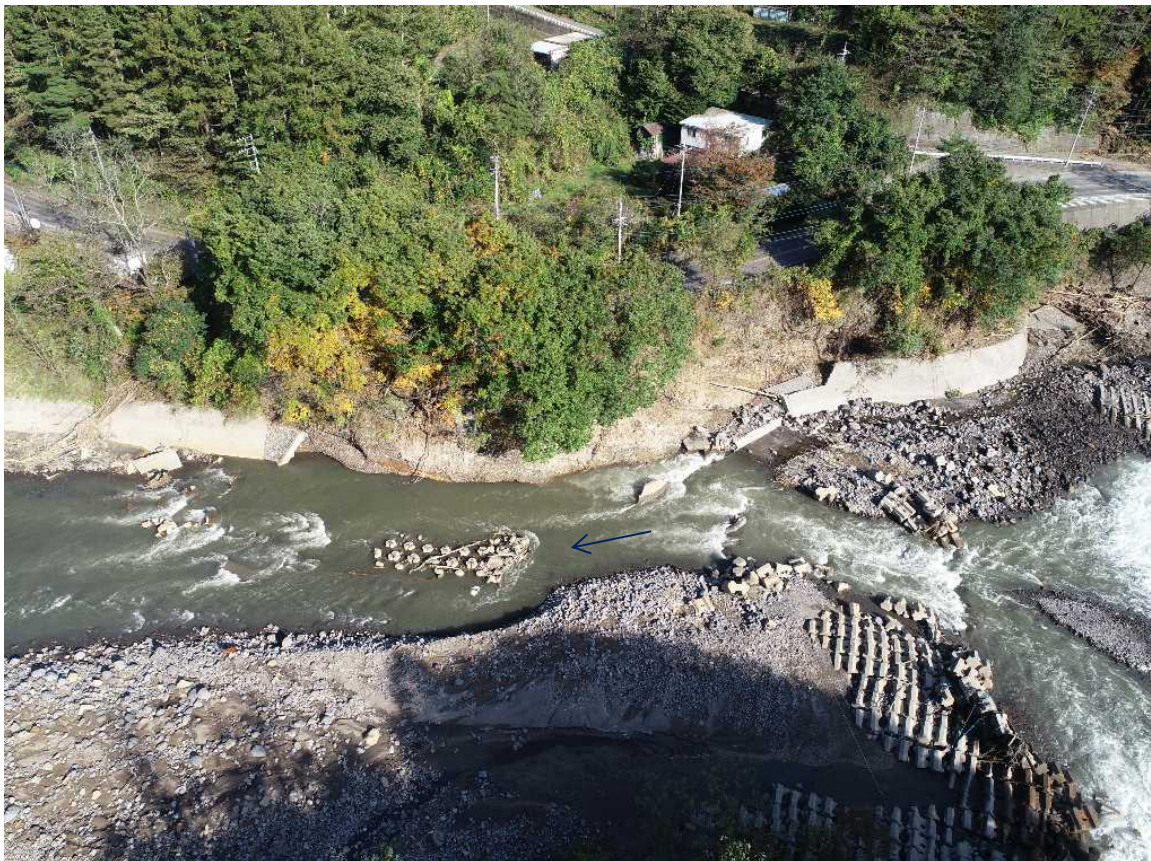
吾妻川 被災状況（嬬恋村鎌原）
