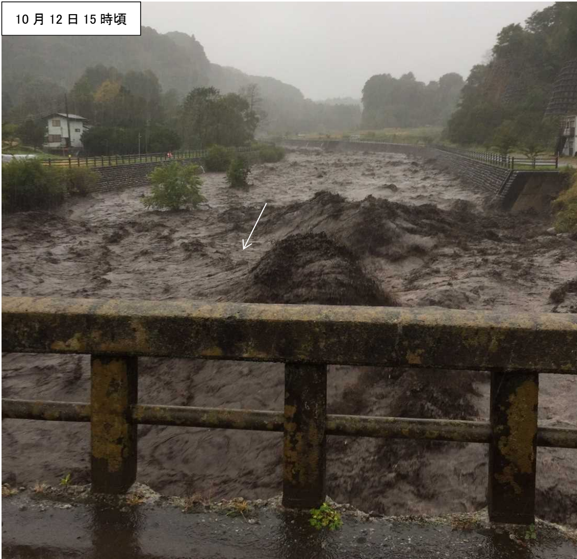
吾妻川(大前橋) 出水状況 (嬭恋村大前)
