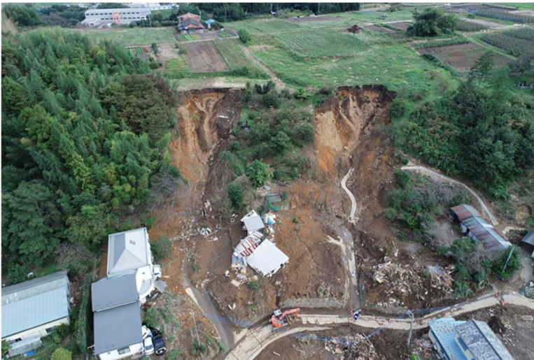
内匠地区 被災状況 (富岡市内匠)
