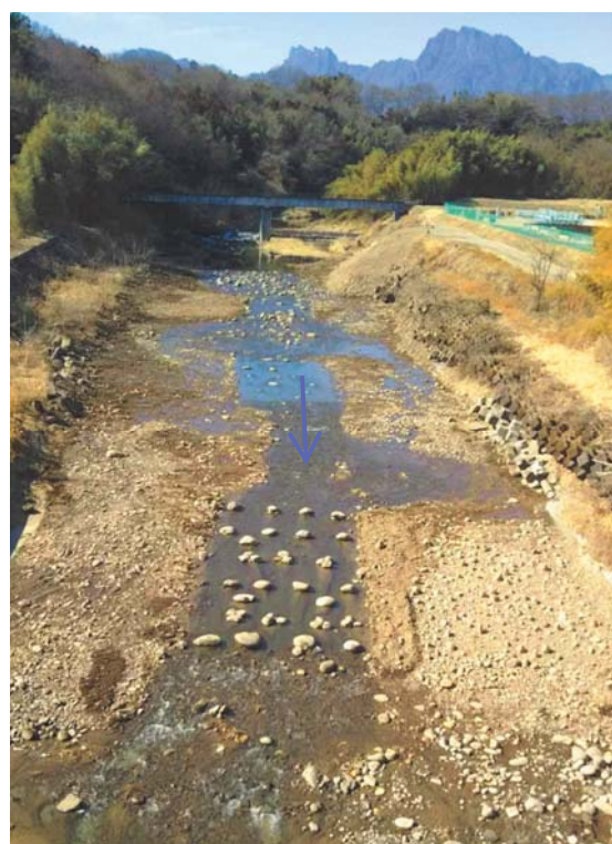
試験施工後の状況（H31.2.18撮影）
