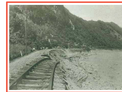
図 2. 2 カスリーン台風による災害状況（国道 17 号線、上越線の崩壊）
