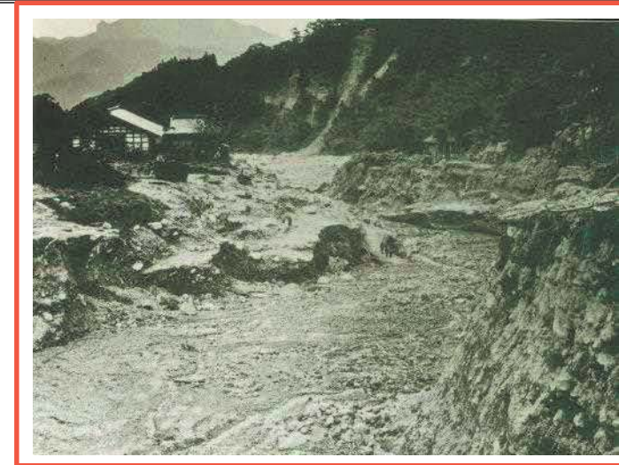
図 2. 1 カスリーン台風による災害状況（山津波（土石流）による災害、赤城村）
