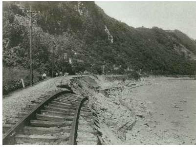
図 2.1 カスリーン台風による災害状況及び水害被害図 (国道 17 号、上越線の崩壊)
