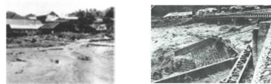
図 2.2 伊勢湾台風による災害状況（草軽電気鉄道橋梁の流出、吾妻川）
