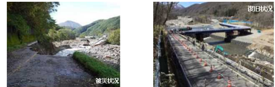
図 2.3 令和元年東日本台風による災害状況（鳴岩橋、吾妻川）
