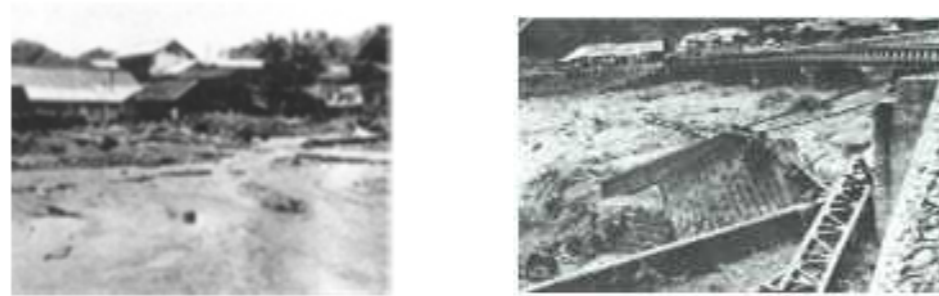
図 2.2 伊勢湾台風による災害状況（草軽電気鉄道橋梁の流出、吾妻川）
