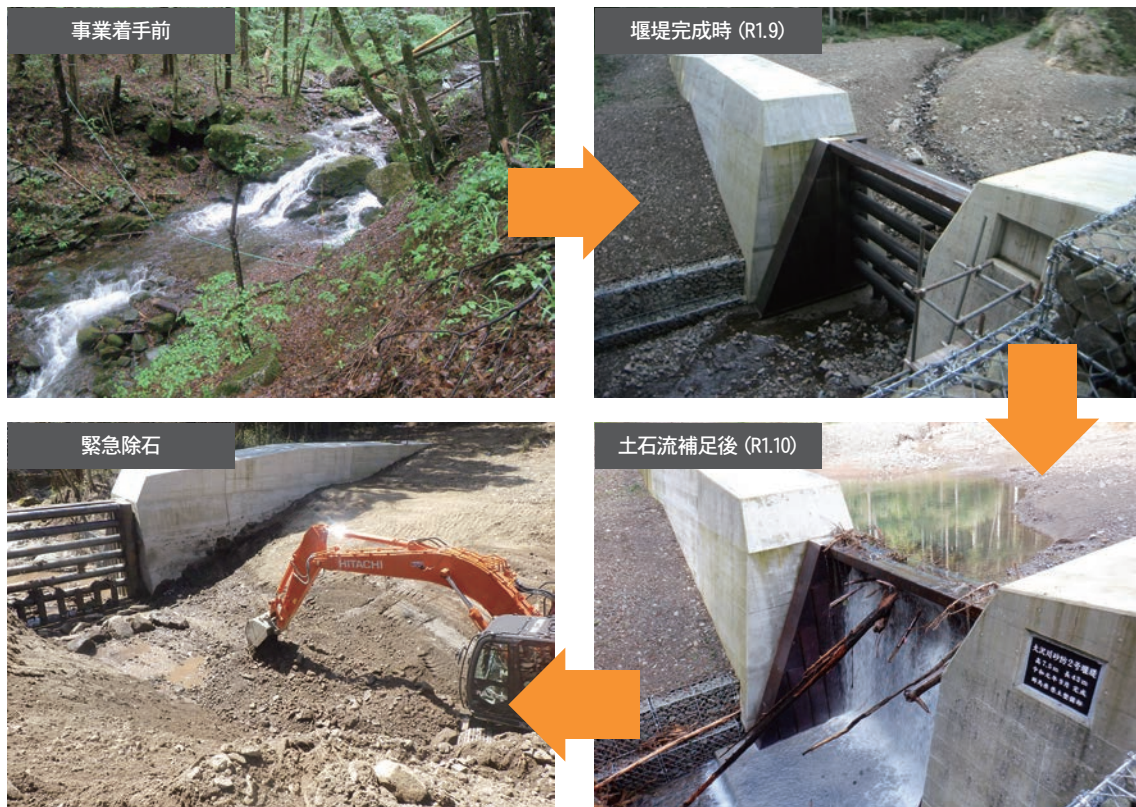
図17 砂防堰堤による土石流補足事例（大沢川2号堰堤）
