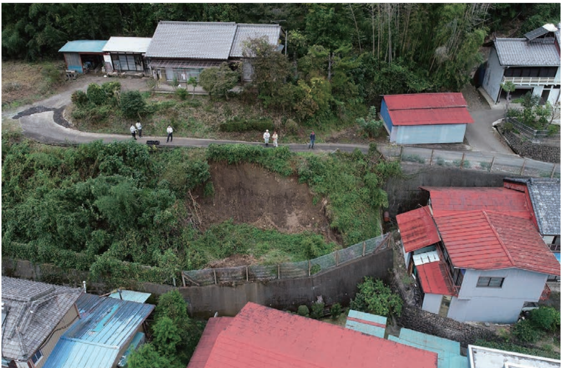
図 18 待受擁壁によるがけ崩れ捕捉事例（中島地区）
