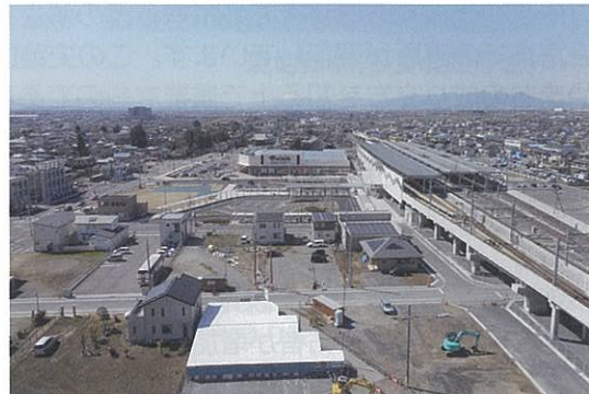
整備が進む伊勢崎駅周辺の土地区画整理事業
