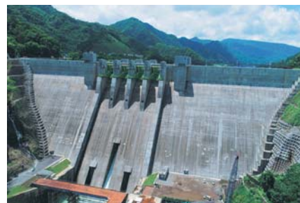
八ツ場ダム(下流側より)
