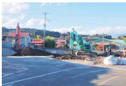
解体作業が進む役場旧庁舎跡地
