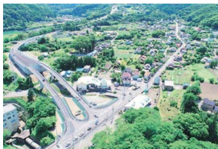
供用開始となった上信自動車道 祖母島～箱島バイパス
