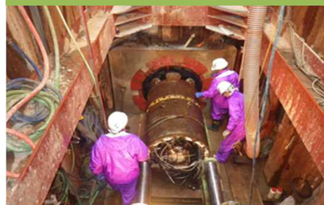
伊勢崎幹線管渠整備状況（過年度）
