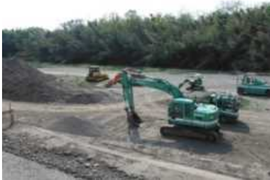
建設発生土ストックヤードの整備による 残土の有効活用の促進
