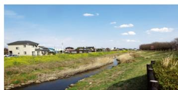
緩傾斜護岸（石田川 太田市）
