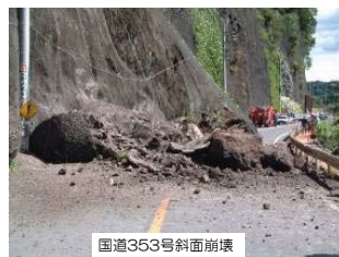
国道353号斜面崩壊
