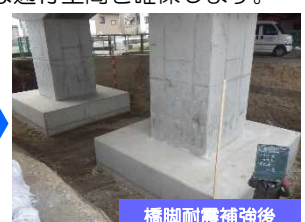
橋脚耐震補強後
