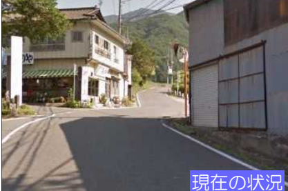
県道上発知材木町線 透門橋工区
