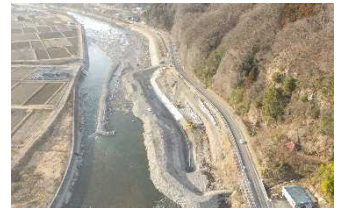
国道353号 村上工区 施工状況
