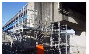
県道高崎神流秩父線 城南大橋 施工状況
