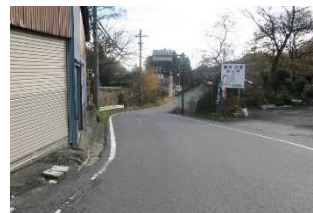
道路幅狭小・線形不良
