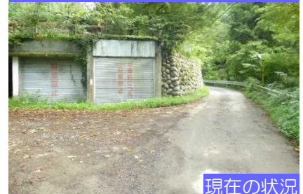
県道上藤生大州線 梅田工区
