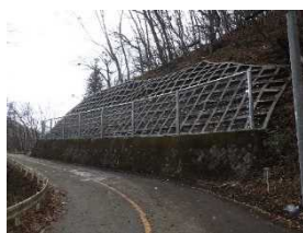
対策後(完成区間)
