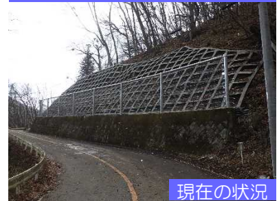
国道401号 片品工区
