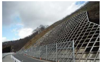
国道120号 菅沼工区 施工状況
