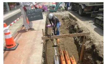
県道前橋館林線 連取町2期工区 施工状況
