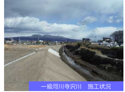
一級河川寺沢川 施工状況
