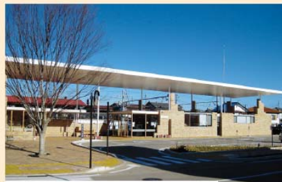
上州富岡駅周辺整備 (富岡市)
