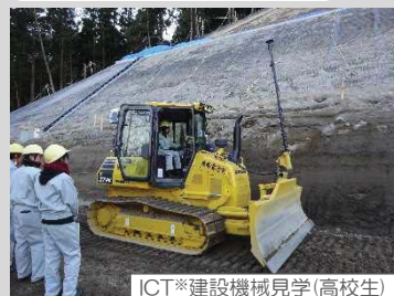
ICT※建設機械見学(高校生)
