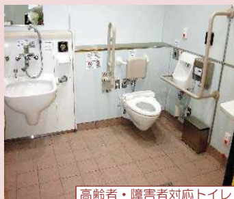
高齢者・障害者対応トイレ
