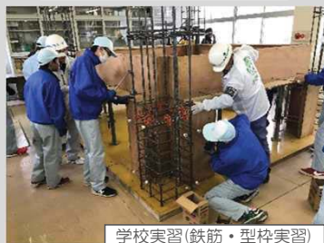
学校実習(鉄筋・型枠実習)
