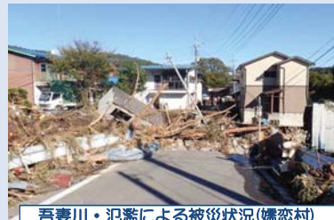
吾妻川・氾濫による被災状況(嬭恋村)
