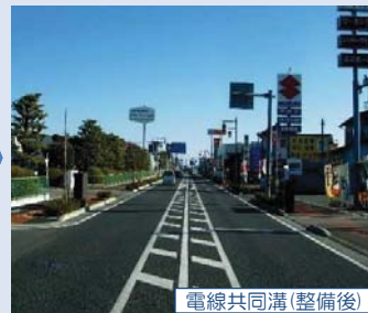
電線共同溝(整備後)
