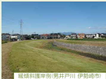
緩傾斜護岸例(男井戸川 伊勢崎市)
