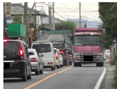
現道区間(2車線) (幅員が狭く大型車規制区間がある)
