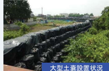
大型土嚢設置状況
