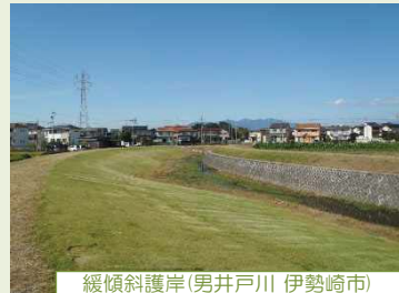
緩傾斜護岸(男井戸川 伊勢崎市)
