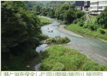
瀬と淵を保全した河川整備(神流川 神流町)
