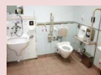
高齢者・障害者対応トイレ
