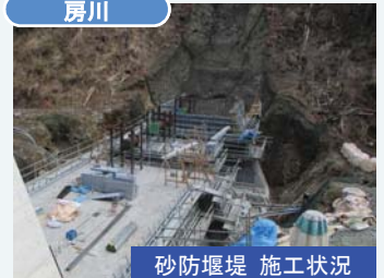
砂防堰堤 施工状況
