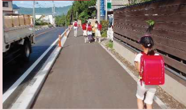
通学路の歩道整備
