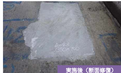
実施後（断面修復）
