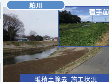
堆積土除去 施工状況
