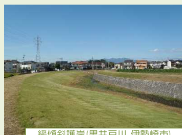
緩傾斜護岸(男井戸川 伊勢崎市)
