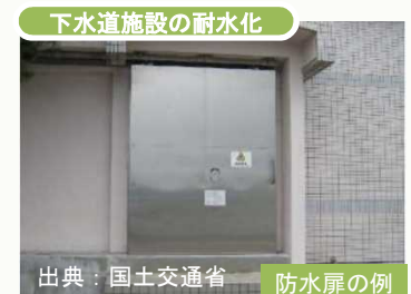
下水道施設の耐水化
