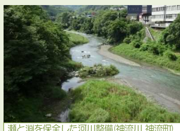
瀬と淵を保全した河川整備(神流川 神流町)
