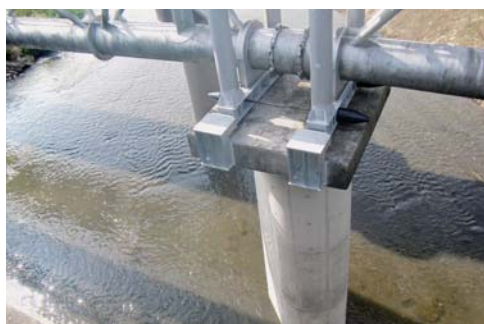
〔東毛工業用水道水管橋*耐震化〕
