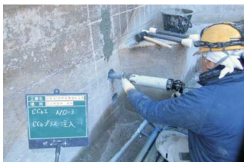
〔渋川工業用水道沈澱池*補強〕
