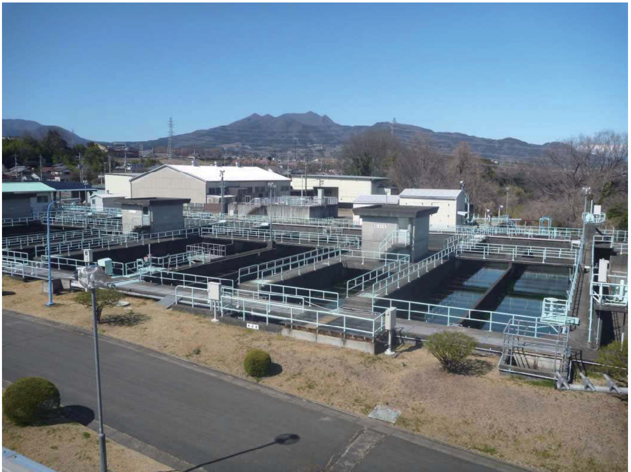
渋川工業用水道事務所 沈澱池
