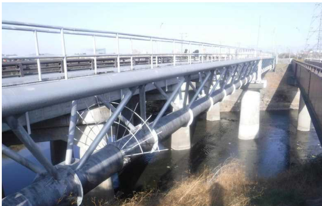
東毛工業用水道事務所 東橋水管橋
