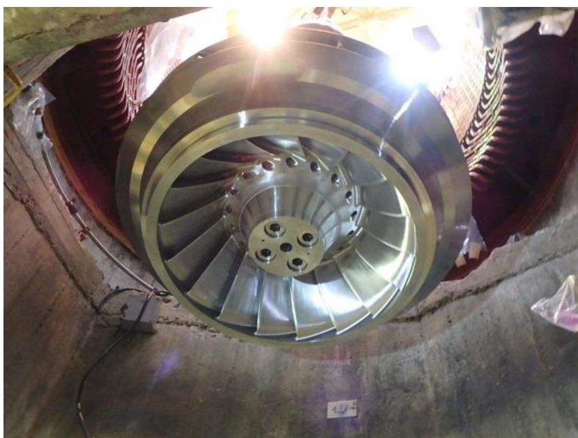
湯川発電所 吊り込み中のランナ
