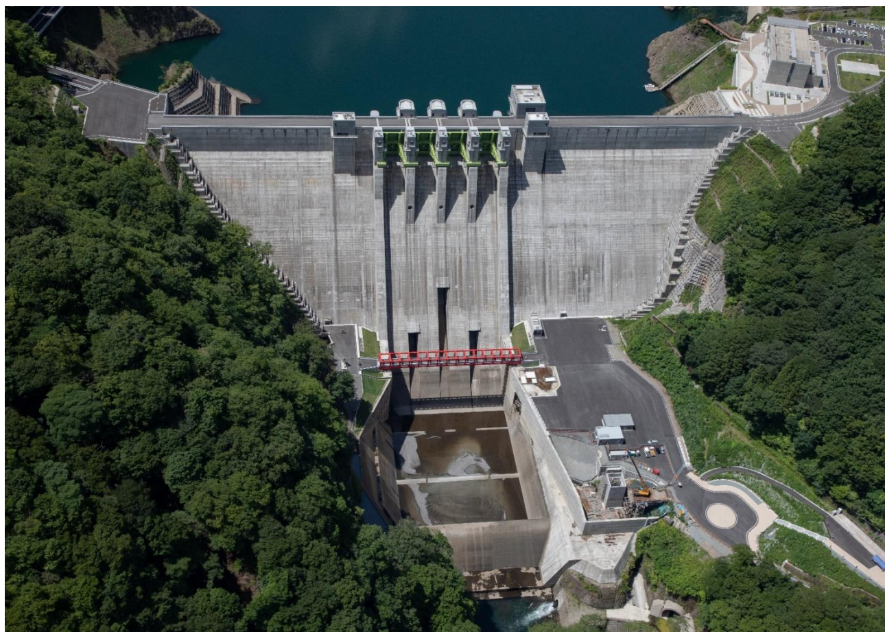
ハツ場発電所
