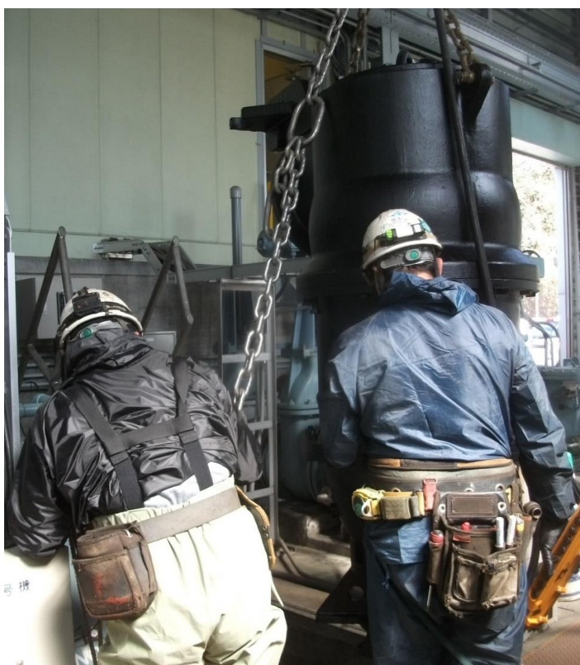
澁川工業用水道事務所 揚水ポンプ分解点検工事
