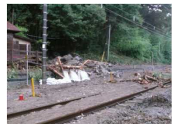
大木平沢の土砂災害(沼田市) (H28年9月台風13号)
