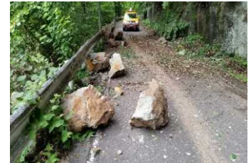
国道254号(下仁田町) の落石状況(H28年6月)
