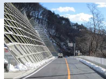
国道120号 落石対策(片品村)
