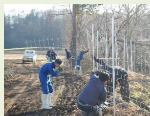
(侵入防止柵の設置)
