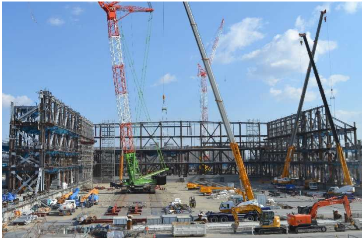
△ ①会議・展示施設の鉄骨工事の様子
