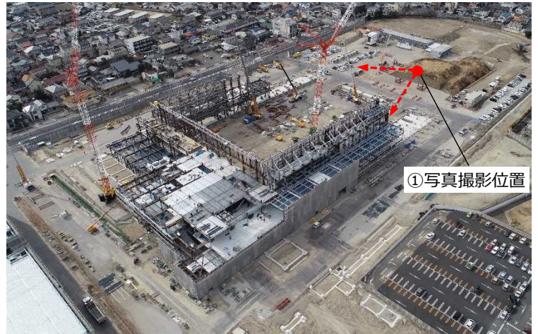
△ ②敷地上空からの工事の様子
