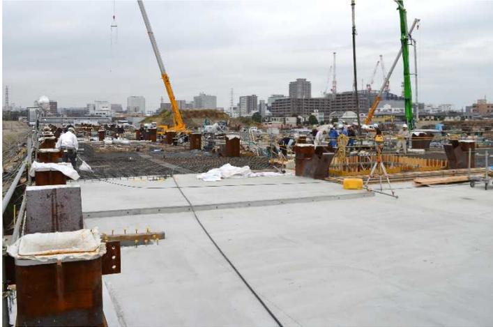
△ ①1階床の鉄筋工事及びコンクリート工事の様子
