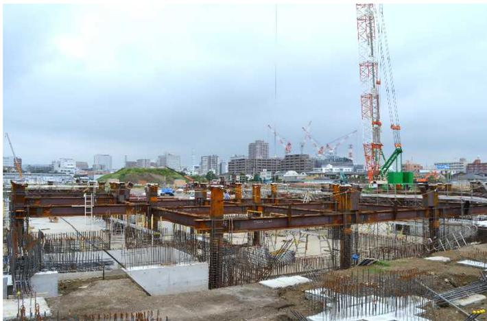
△ ①地下部分の鉄骨を組み立てている様子
