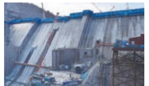
建設が進むハツ場ダム(30年2月)
