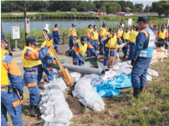
訓練で「月の輪工法」の手順を確認する
