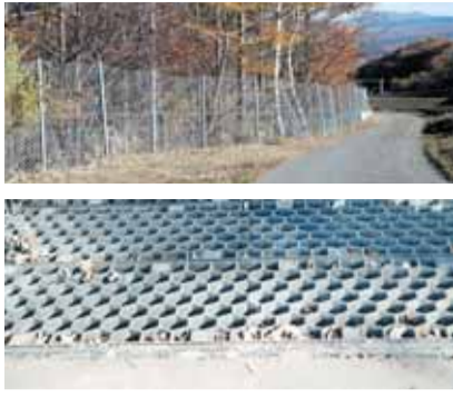
上：山際に設置した金網柵 下：道路に設置した網目の形状が工夫されているグレーチング。幅約8cmの六角形の網目をシカが警戒 (いずれも嬭恋村)
