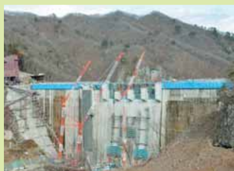
9割完成したハツ場ダム
