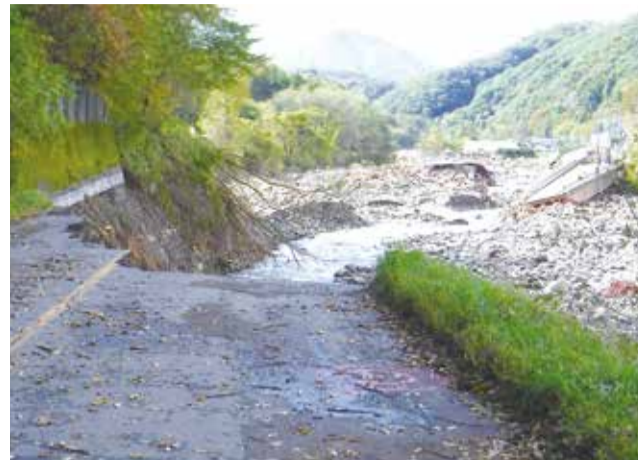
吾妻川に崩落した国道144号
