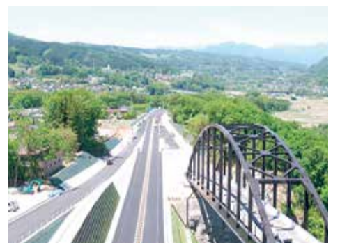
開通した岡崎IC(東吾妻町)
