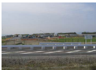
高崎玉村スマートIC進捗状況 (平成25年度末供用予定)
