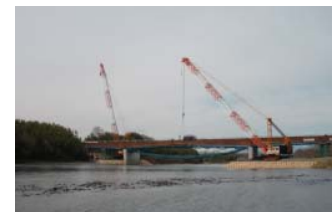
平成26年度上期開通に向けて工事推進中 (平成25年2月利根川新橋施工状況)
