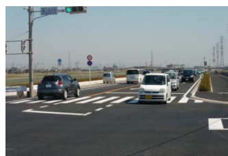
東毛広域幹線道路進捗状況 (平成25年3月境工区開通)
