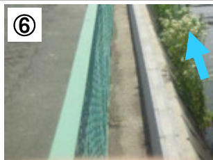
⑥ 護岸嵩上状況(諏訪橋付近)
