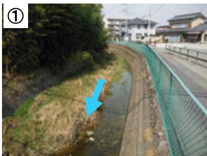
① 現況河道(未改修区間:今井橋上流)
