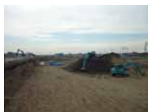
【C池】(工事中)
