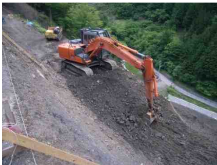
排土作業状況
