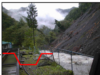
河道の付け替え (流路工予定)
