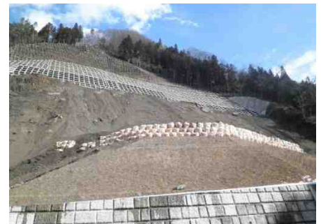
押さえ盛土状況
