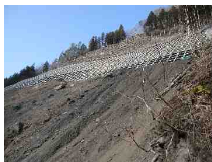
法切工・法枠工(完了箇所)
